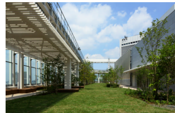
「スカイパーク」(約1,000㎡) 超高層ビルとして都心部最大規模となる屋上庭園
