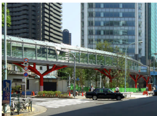
アークヒルズと接続する新設デッキ
