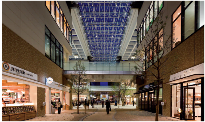
東西2棟の屋根を活用した柱のないアーケード
