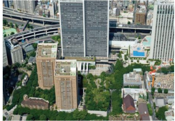
アークヒルズ:大規模な屋上緑化や並木の整備
