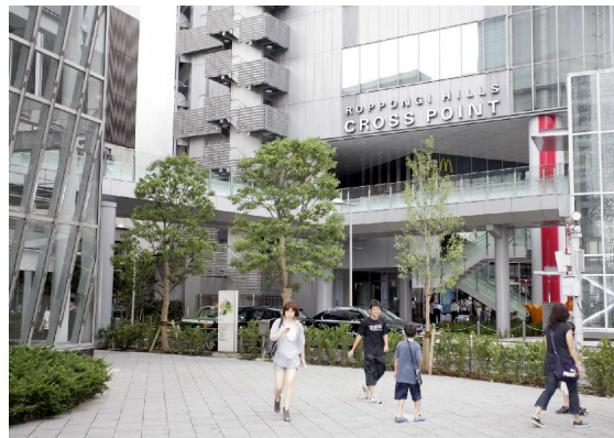
この度開通した、連絡ブリッジ
